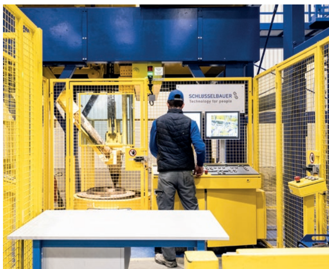
Procesy zalewania oraz podawania i pobierania form z magazynu regałowego są monitorowane z centralnego panelu sterowania.
