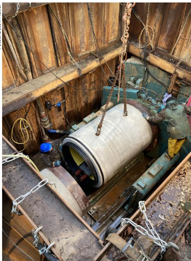
**Bild 2:** Einheben des Rohres in den Startschacht über zwei eingegossene Kugelkopfanter
