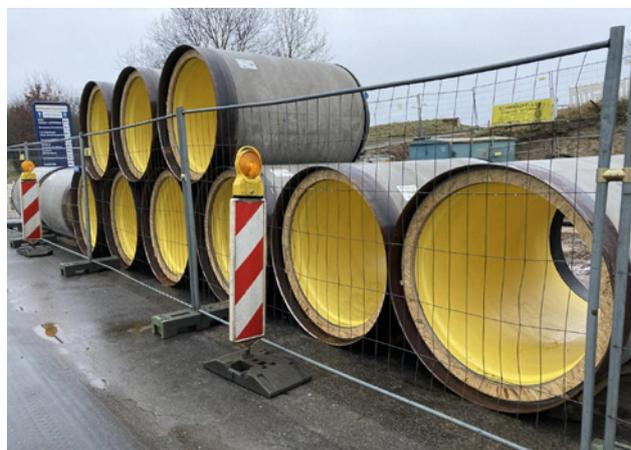
**Bild 1:** Zwischenlager der schalungserhärteten Perfect Jacking Pipes DN 1200 mit HDPE-Liner auf der Baustelle in Haren
