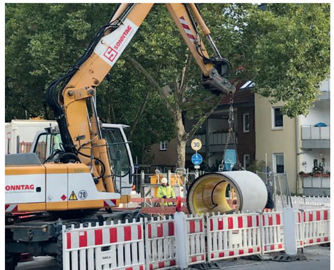
Chantier de Datteln : mise en place dans la fosse de départ, tuyau avec lubrification à la bentonite.
