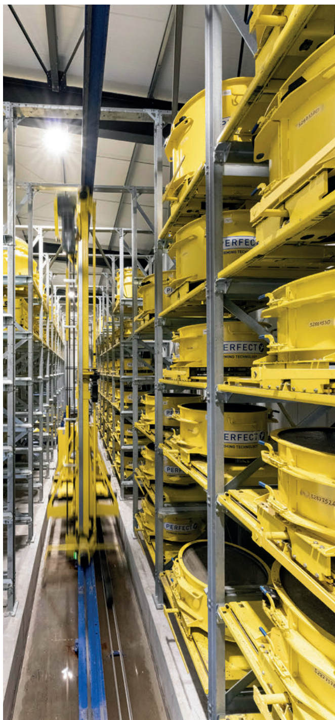
Un entrepôt à rayonnages, zone de séchage efficace et peu encombrante pour les produits durcis moule
